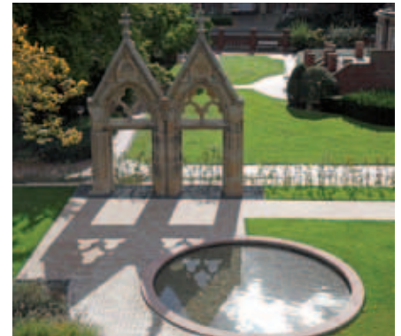
Das fertige Doppelportal
